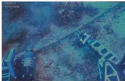
Undervannsfoto fra ROV viser skjæringsverktøyet (venstre) og den gripende armen (høyre) mens den utfører kabelsnittet.
