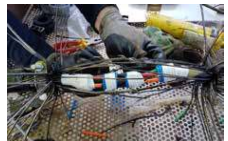
Her spleises den originale kabelen (til venstre) til den nye kabelen (høyre) ombord på PHILIA
