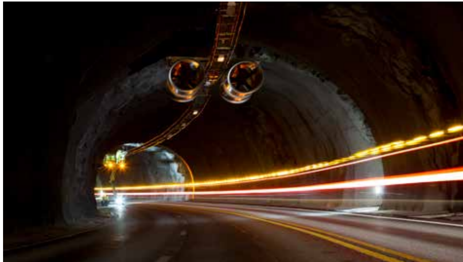
Scanmatic Elektro. Rehabilitering av Byfjord og Mastrafjord tunnelne i Rogaland i 2014.
